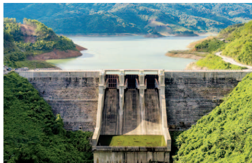
Thủy điện A Vương
