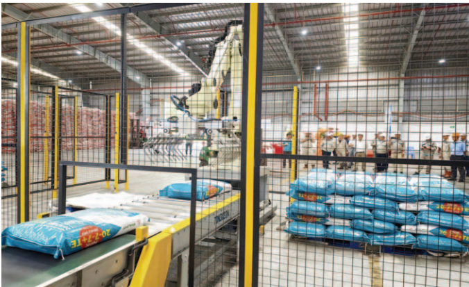
Hệ thống hiện đại, đồng bộ, khép kín với các hạng mục kết cấu, tuyến băng tải, robot cùng các thiết bị vận hành tự động hóa
