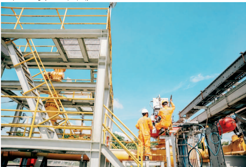
Người lao động PV GAS thực hiện công tác bảo dưỡng công trình khí
