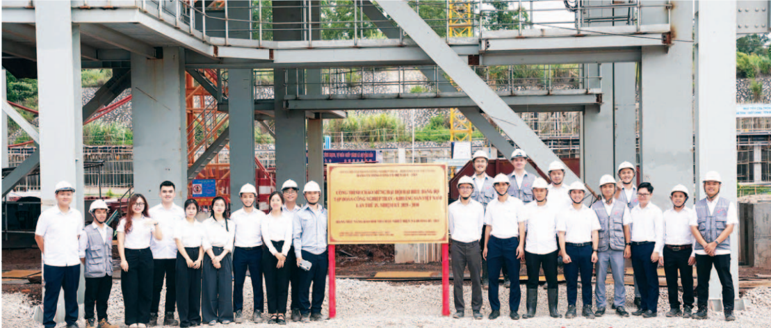
Hoàn thành hạng mục nâng bao hơi Nhà máy Nhiệt điện Na Dương II
