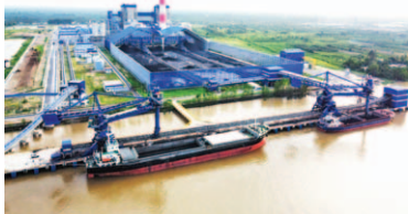
Thiết kế, chế tạo, tích hợp hệ thống vận chuyển than Nhà máy Nhiệt điện Sông Hậu 1 Ảnh: Quỳnh Nga
