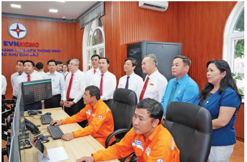
Bi thư Đảng ủy Đặc khu Côn Đảo cùng lãnh đạo EVNHCM và các đại biểu tham quan phòng điều hành lưới điện thông minh của đặc khu được đưa vào vận hành từ 1/2/2026
