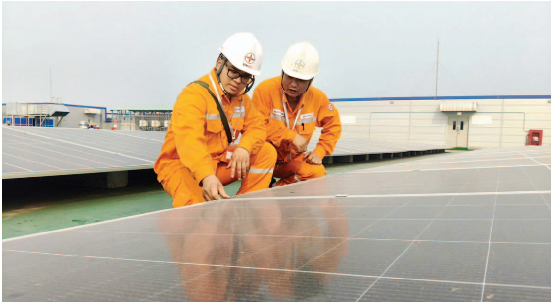
Công ty TNHH Precision Technology Component Fulian, tỉnh Bắc Ninh lắp đặt điện mặt trời mái nhà tự dùng
