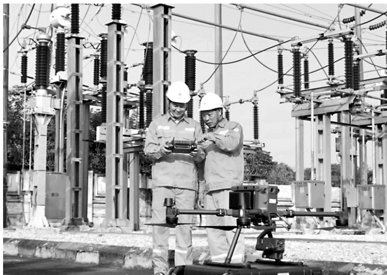
Nhân viên điện lực EVNNPC điều khiển thiết bị UAV ngoài hiện trường
