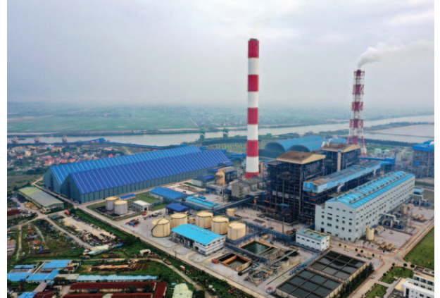
Nhà máy Nhiệt điện Thái Bình 2
