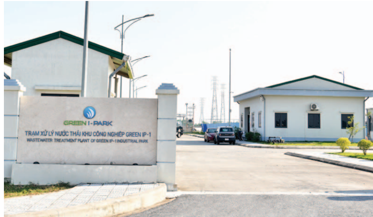
Toàn cảnh Nhà máy xử lý nước thải
