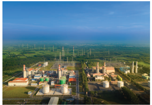
Cụm Nhà máy điện khí Nhơn Trạch
