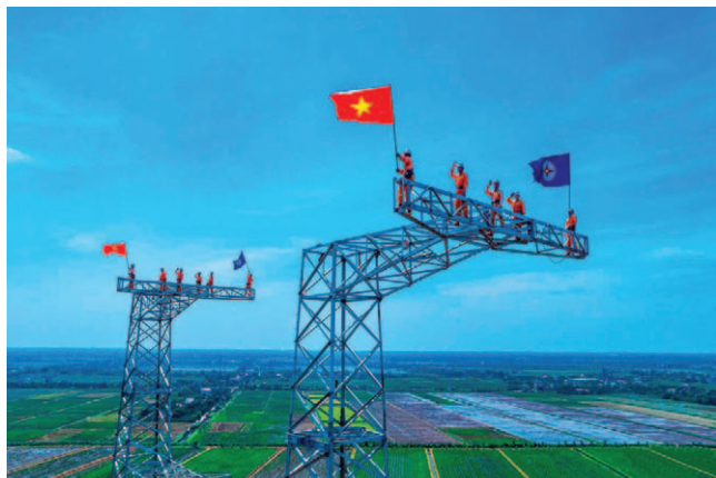
Thi công đường dây 500kV mạch 3
