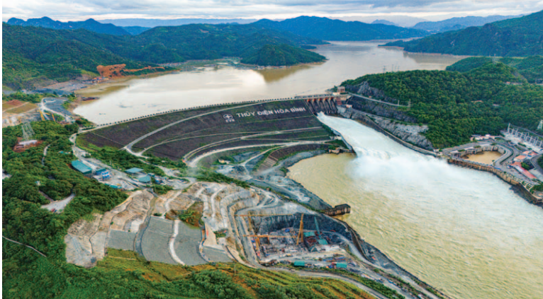
Dự án nhà máy Thủy điện Hòa Bình mở rộng có tổng mức đầu tư hơn 9.200 tỷ đồng do Tập đoàn Điện lực Việt Nam (EVN) làm chủ đầu tư
