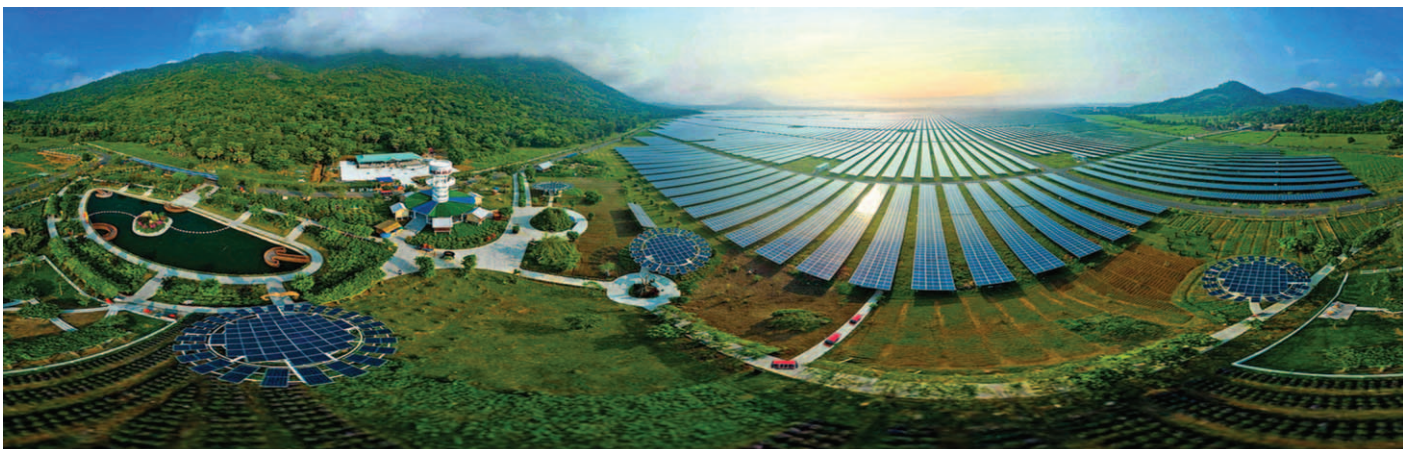
Nhà máy điện mặt trời An Hảo
