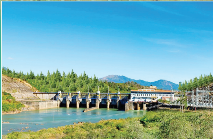
Thủy điện Se San 3A
