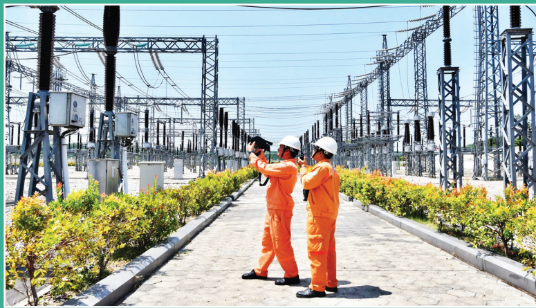
Cán bộ Công ty CP Đầu tư phát triển điện Se San 3A kiểm tra tại nhà máy
