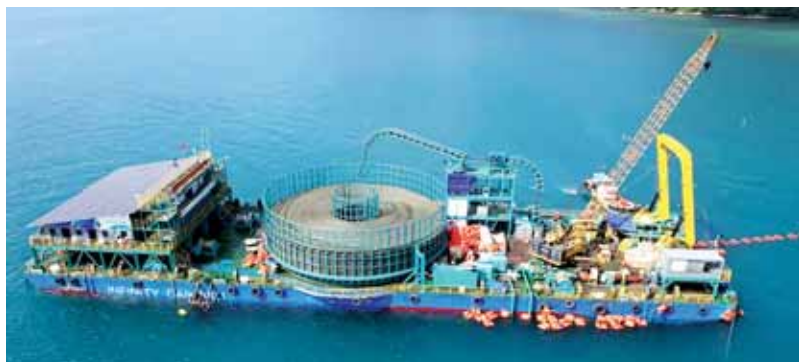
Thị công kéo cáp ngầm xuyên biển cấp điện cho Côn Đảo (công trình khánh thành ngày 19/12/2025)
