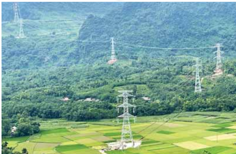
Dự án đường dây 500kV Lào Cai – Vĩnh Yên là công trình trọng điểm cấp bách quốc gia góp phần đảm bảo an ninh năng lượng, tăng cường liên kết vùng khu vực phía Bắc. Công trình khánh thành ngày 17/10/2025
