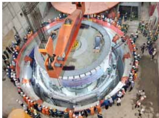
Hạ đặt rotor Tổ máy số 1 Dự án Thủy điện Hòa Bình mở rộng, công trình đã khánh thành ngày 19/12/2025
