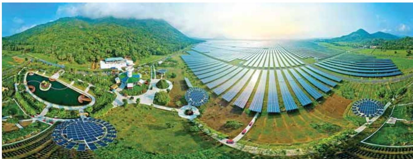
Nhà máy Điện mặt trời An Hào (An Hao Solar) tại tỉnh An Giang có công suất thiết kế 210 MWp, được xây dựng trên diện tích 275 ha
