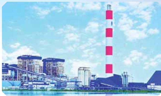
Nhà máy Nhiệt điện Sông Hề 1 - "àim saóng" trong xây dựng công nghiệp vùng lũ lụt
