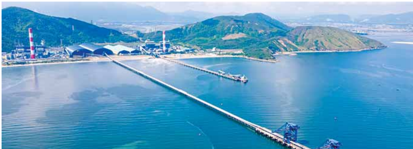
Nhà máy Nhiệt điện Vũng Áng 2
