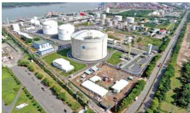
Công trình Kho cảng LNG 1 MMTPA Thị Vải
