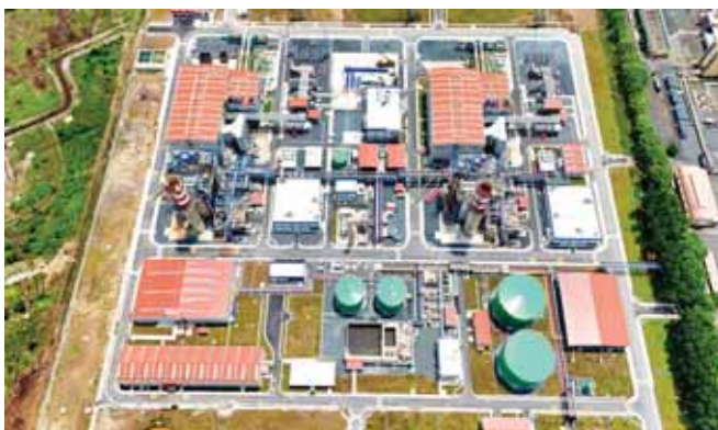
Toàn cảnh cụm dự án Nhà máy điện Nhơn Trạch 3 và 4 - Nhà máy nhiệt điện khí LNG đầu tiên tại Việt Nam
