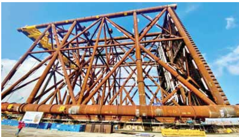
Công trình Chân đế khối thượng tầng Giàn công nghệ trung tâm (CPP) - hạng mục trọng yếu thuộc Dự án phát triển mỏ khí Lô B & 48/95 và Lô 52/97, do công ty thành viên thuộc Tập đoàn Công nghiệp - Năng lượng Quốc gia Việt Nam chế tạo
