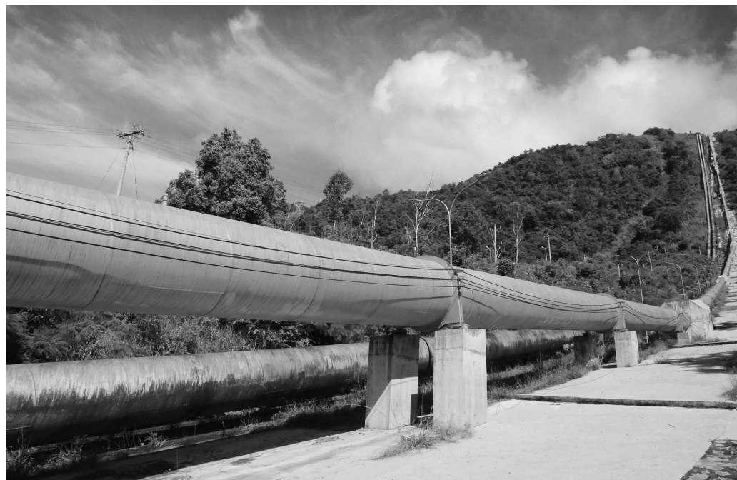
NARIME chế tạo đường ống thủy điện Đa Nhim với cột nước tính toán 900 m
