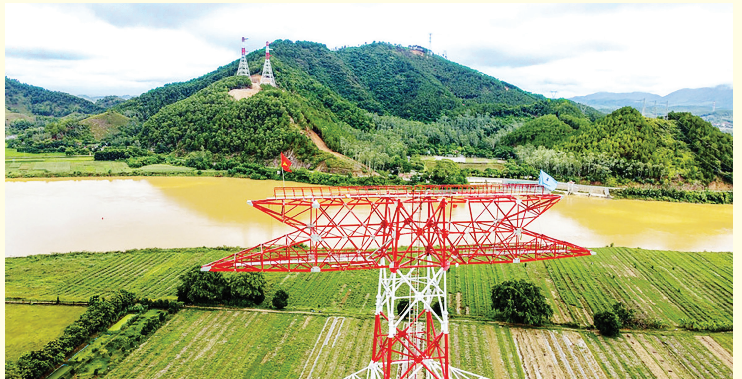
Thị công đường dây 500kV mạch 3 đoạn Quảng Trạch - Quỳnh Lưu trên địa bàn tỉnh Nghệ An
