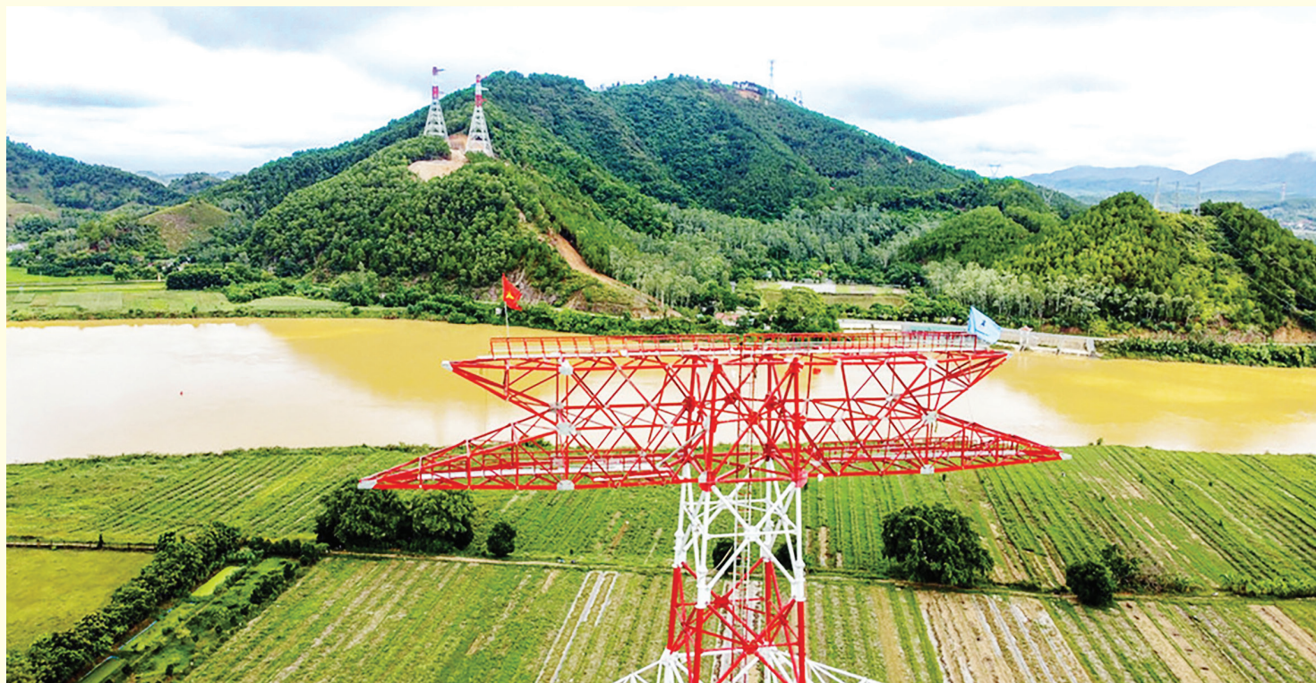
Thi công đường dây 500kV mạch 3 đoạn Quảng Trạch - Quỳnh Lưu trên địa bàn tỉnh Nghệ An
