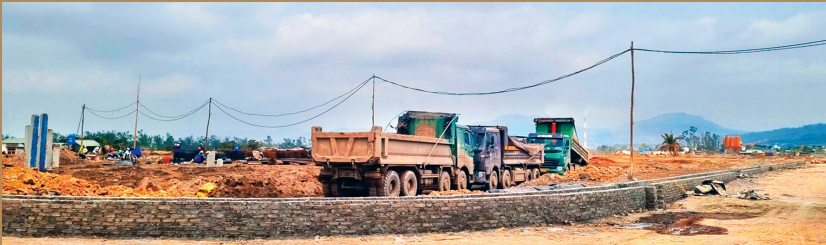
CCN Đông Mai dự kiến tháng 9/2025 sẽ hoàn thiện hạ tầng kỹ thuật thu hút nhà đầu tư.
