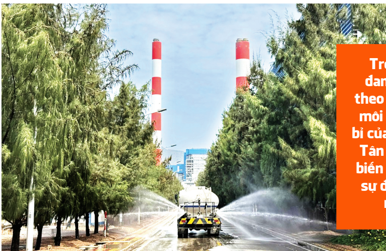
Xe phun rửa đường thường xuyên tại Nhà máy Nhiệt điện Vinh Tân 4
