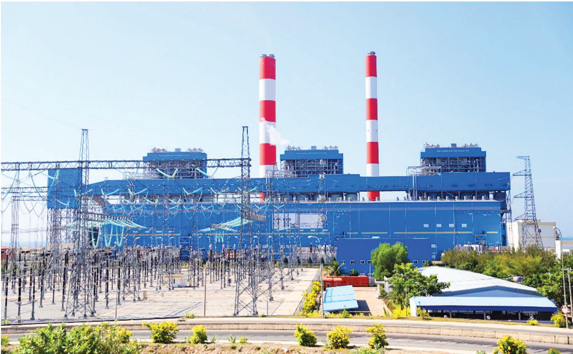
Nhà máy Nhiệt điện Vĩnh Tân 4 - Chi nhánh Tập đoàn Điện lực Việt Nam
