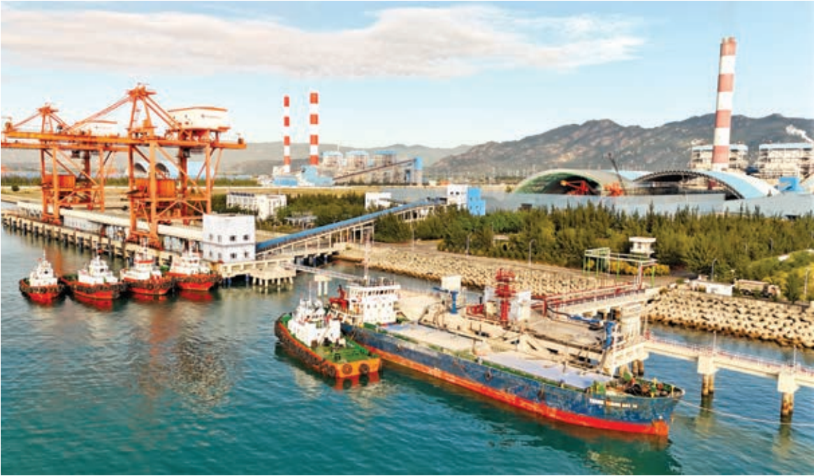
Khuôn viên Nhà máy Nhiệt điện Vĩnh Tân 2 nhìn từ cảng than
