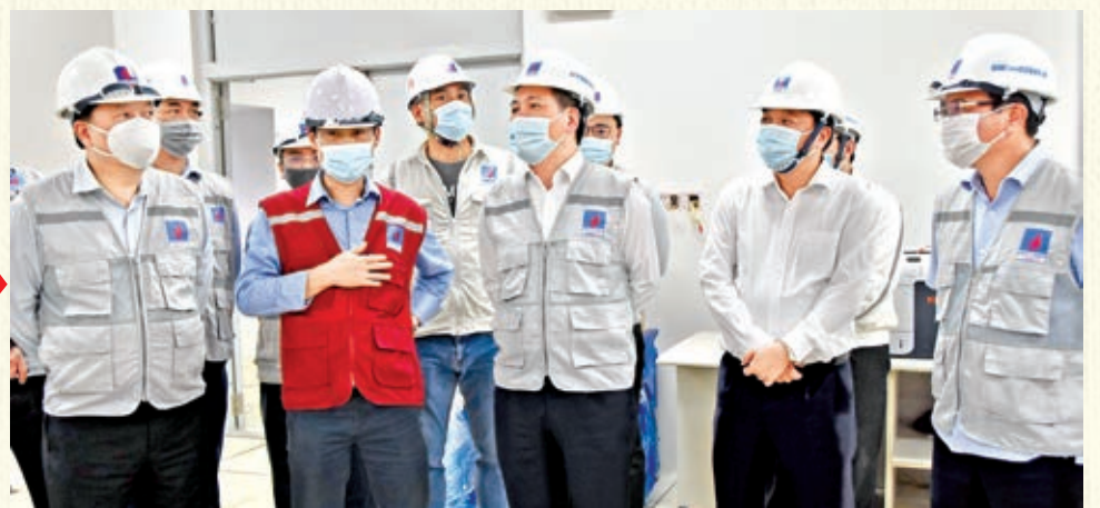
Bộ trưởng Nguyễn Hồng Diên và Đoàn công tác kiểm tra thực tế tại công trường của Nhà máy Nhiệt điện Thái Bình 2 ngày 4/5/2021
