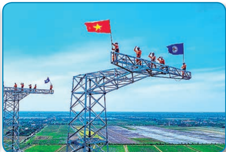
Kỷ tích đường dây 500 kV mạch 3 với thời gian thi công hơn 6 tháng
