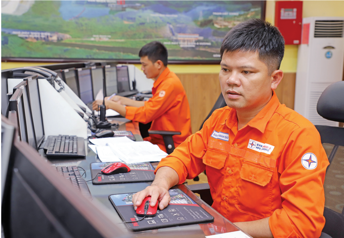
Phòng điều khiển Nhà máy Thủy điện A Vương
