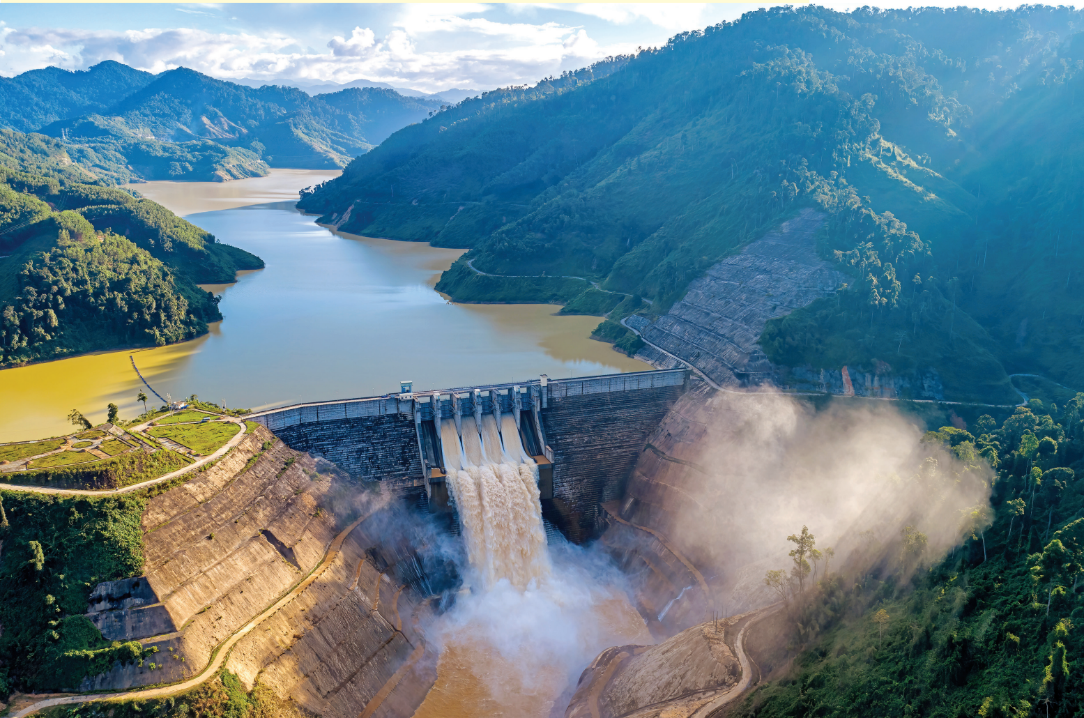
Nhà máy Thủy điện Sông Bung 4 điều tiết nước qua đập tràn
