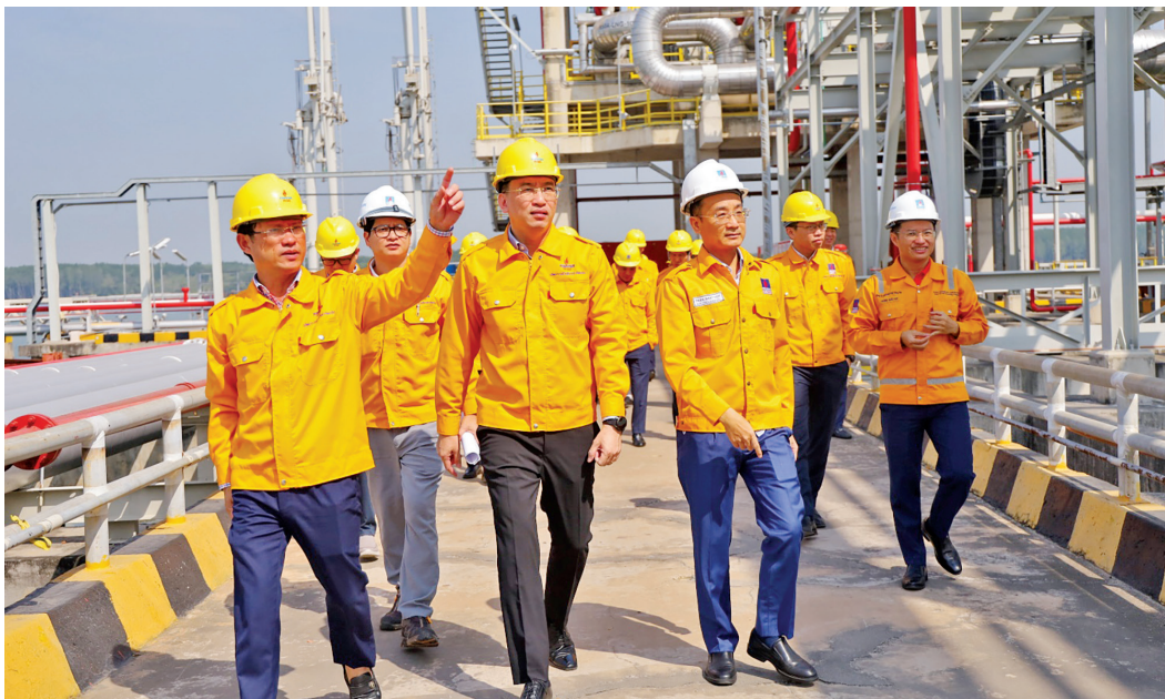
Lãnh đạo PV GAS kiểm tra hoạt động trên công trình khí
